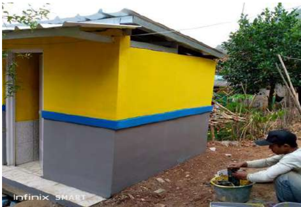
Pembangunan Jamban Sehat Individu Desa Baranangsiang Kecamatan Cipongkor
